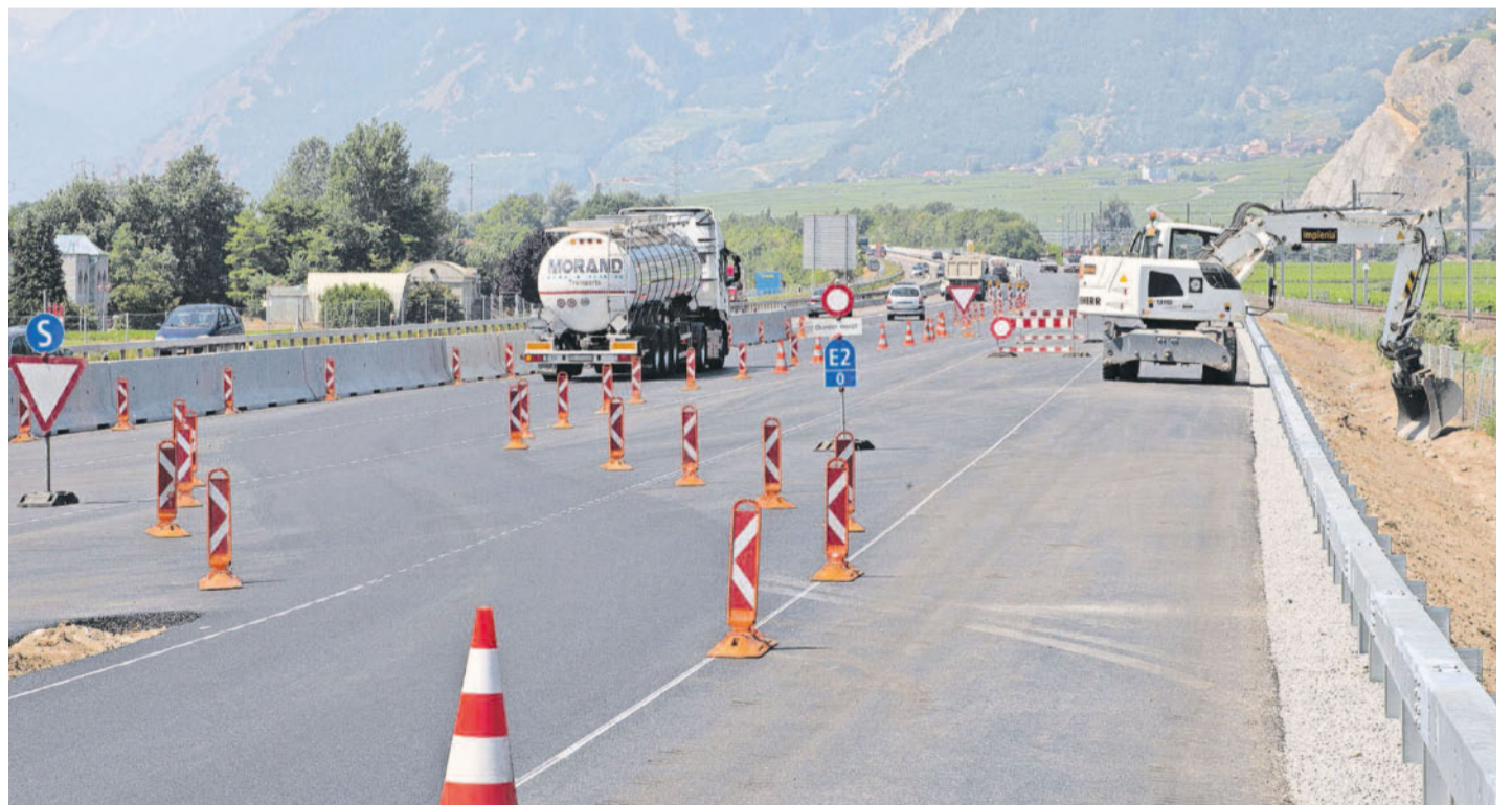
Endphase. Die Hauptarbeiten für die Gesamterneuerung der A9 nehmen Gestalt an.
