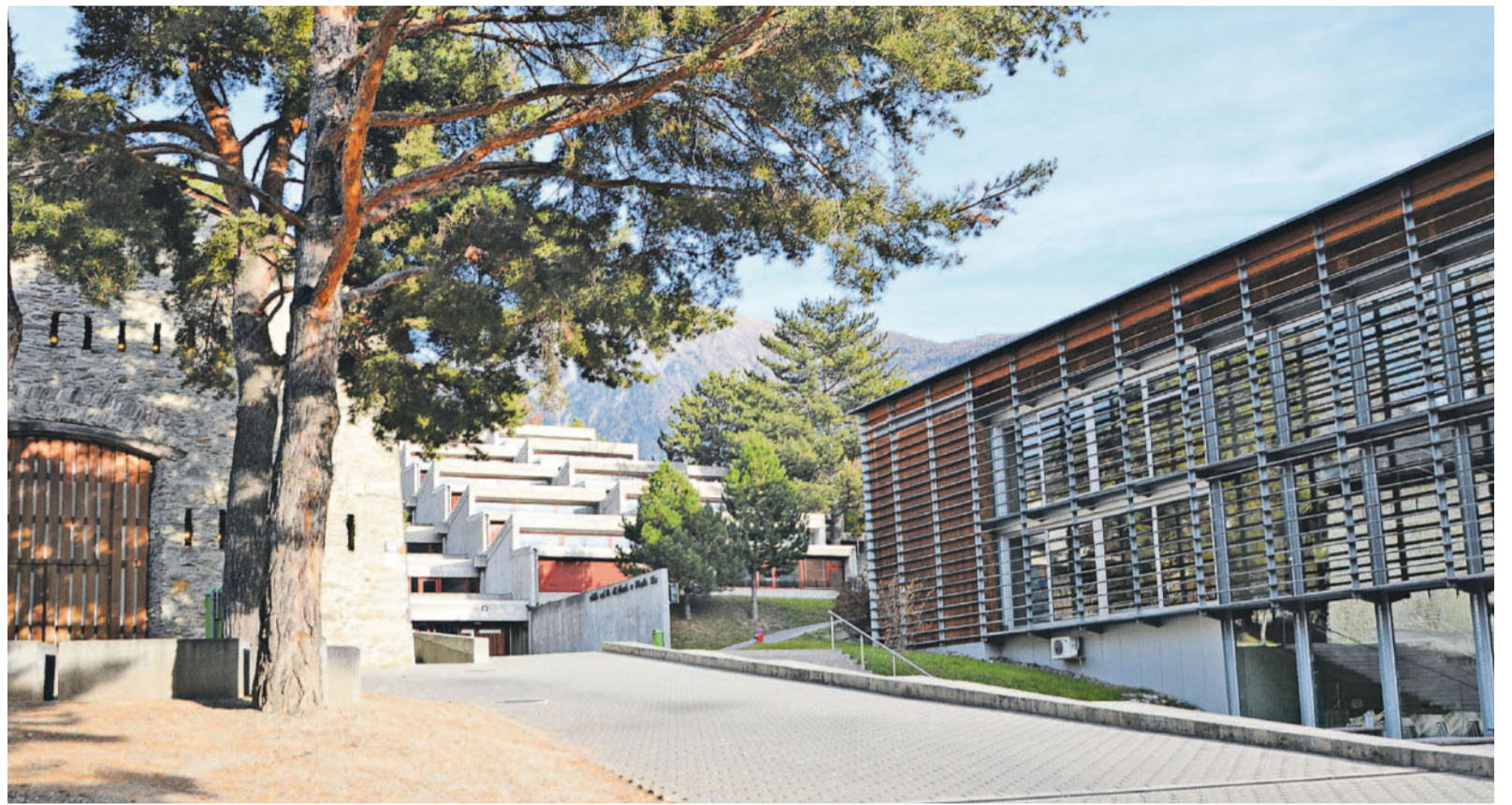
Geschichtsträchtig. Auf dem Areal des Briger Kollegiums fügen sich Bauten aus verschiedenen Epochen zu einer harmonischen Einheit zusammen: der Stall aus dem frühen 19. Jahrhundert (heute Musikpavillon), der Terrassenbau aus den 1960er-Jahren und der 2005 eingeweihte «Neustbau». FOTOS WB
