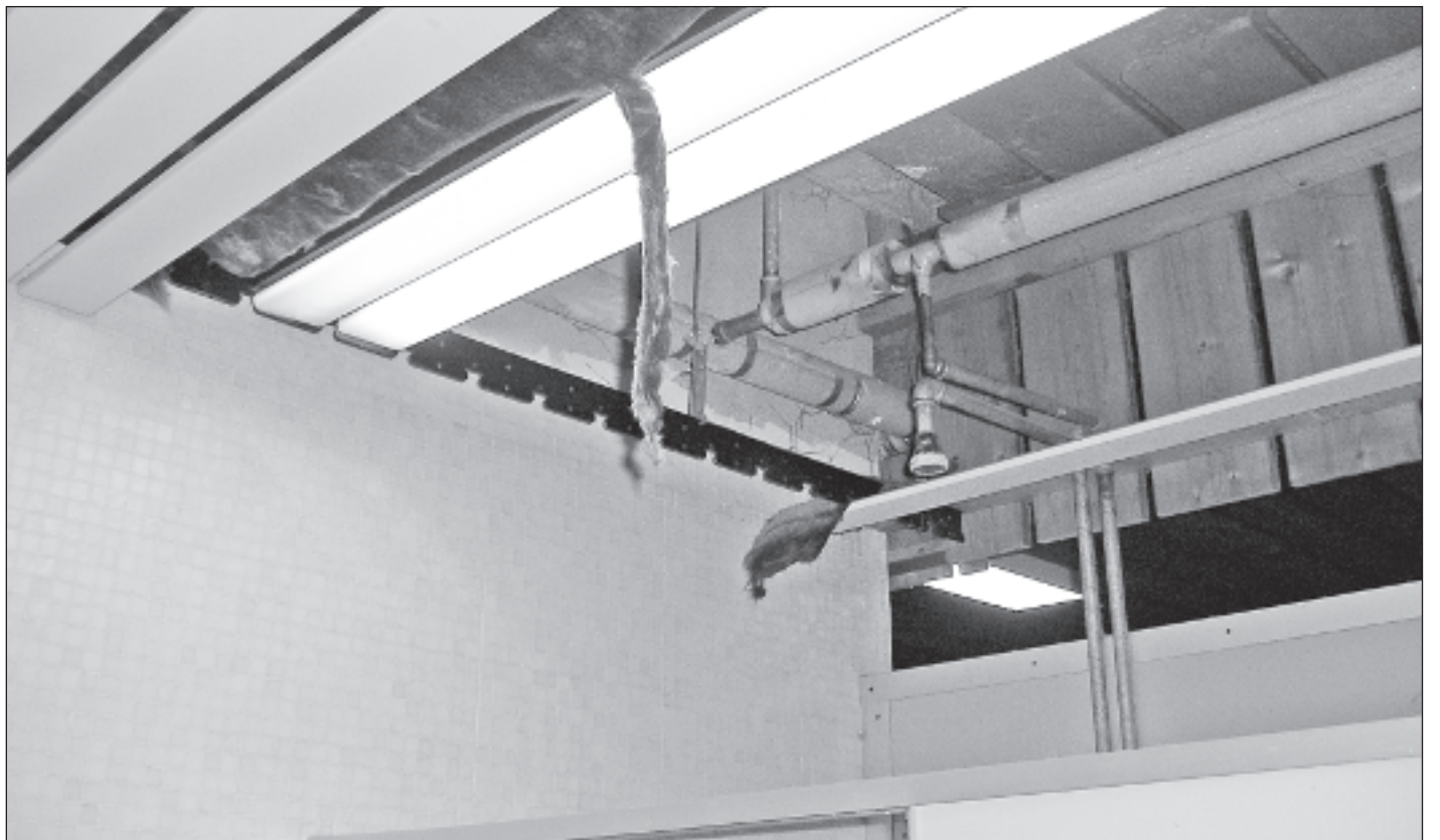
Mehr Baustelle als Dusche: Die sanitären Einrichtungen im Kollegium Spiritus Sanctus. Foto zg
