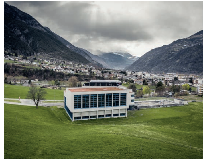
Modern. Die neue Trainingshalle im ehemaligen Schwimmbad von aussen.
