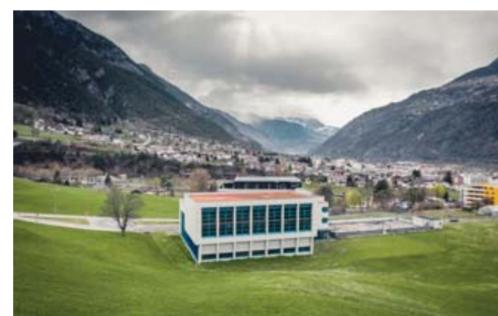
La nouvelle salle d'entraînement aménagée dans l'ancienne piscine, vue de l'extérieur. POMONA.MEDIA/ALAIN AMHERD
