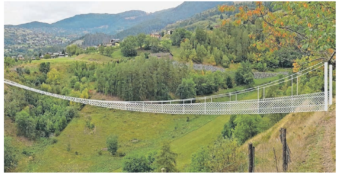
Die Fundamentarbeiten der Hängebrücke zwischen Eischoll und Unterbäch haben begonnen. Bild: zvg
