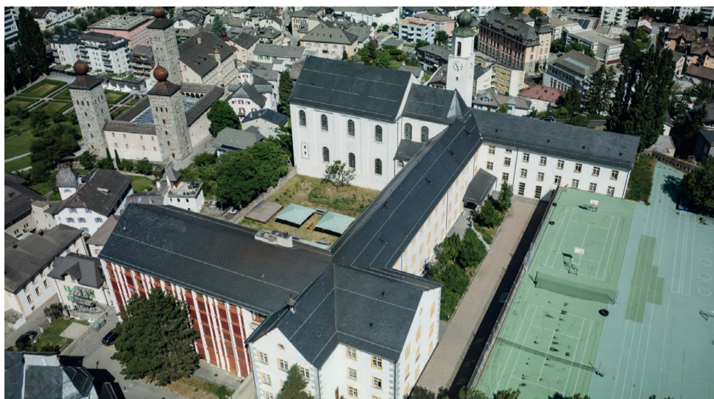
Der Internatstrakt aus den 70er-Jahren (rote Fassade) des Briger Kollegiums wird komplett umgebaut, der alte Teil saniert.
