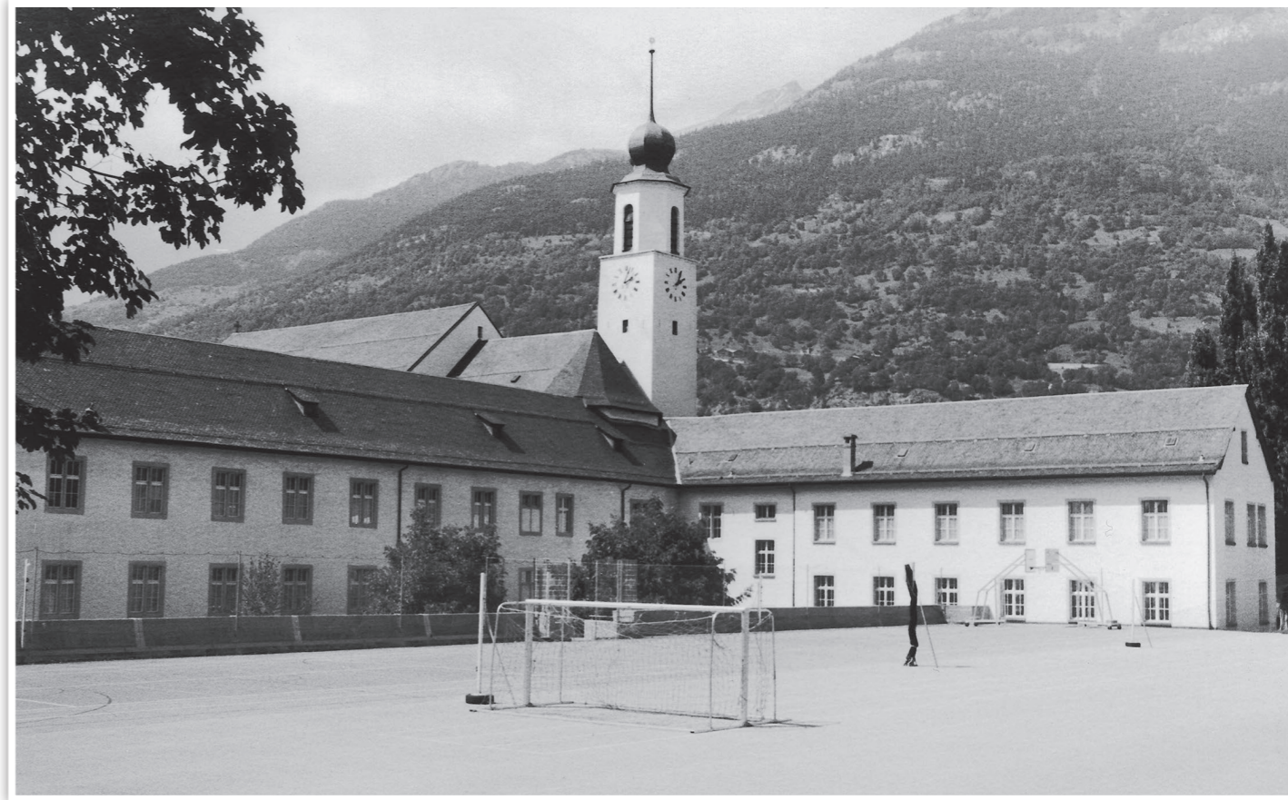
Sportplatz über der neuen Turnhalle des Kollegiums (Walliser Bote), 1975.
