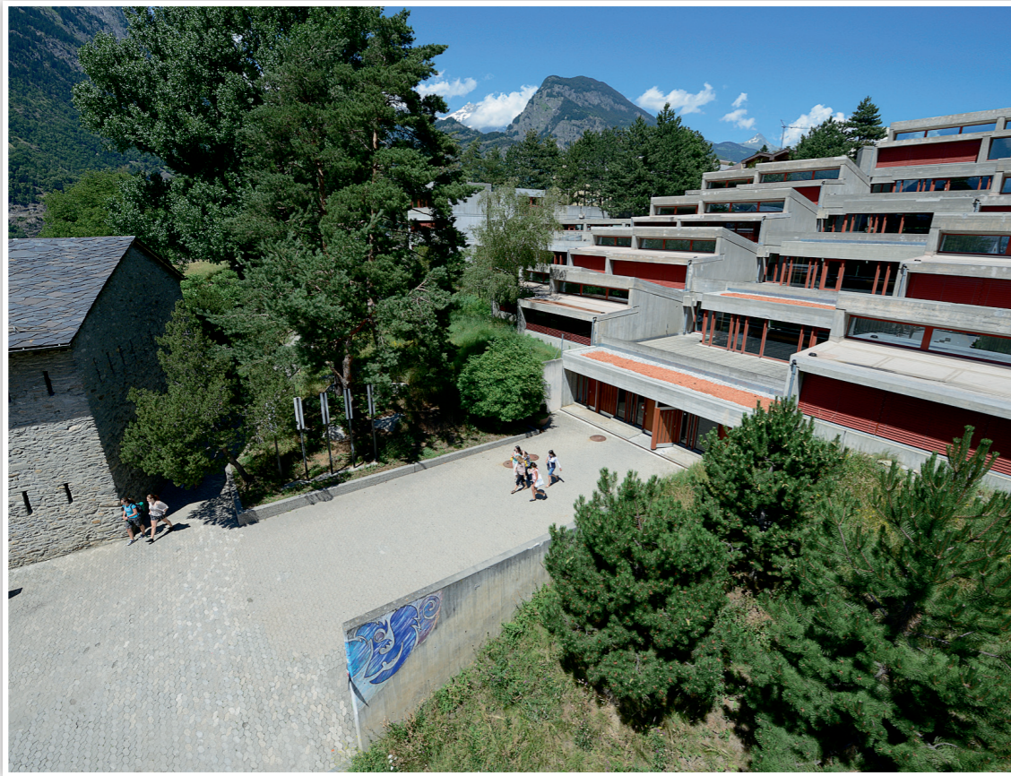
Musikgebäude (Scheune aus napoleonischer Zeit) und Terrassenbau gegen Norden, 2012.
