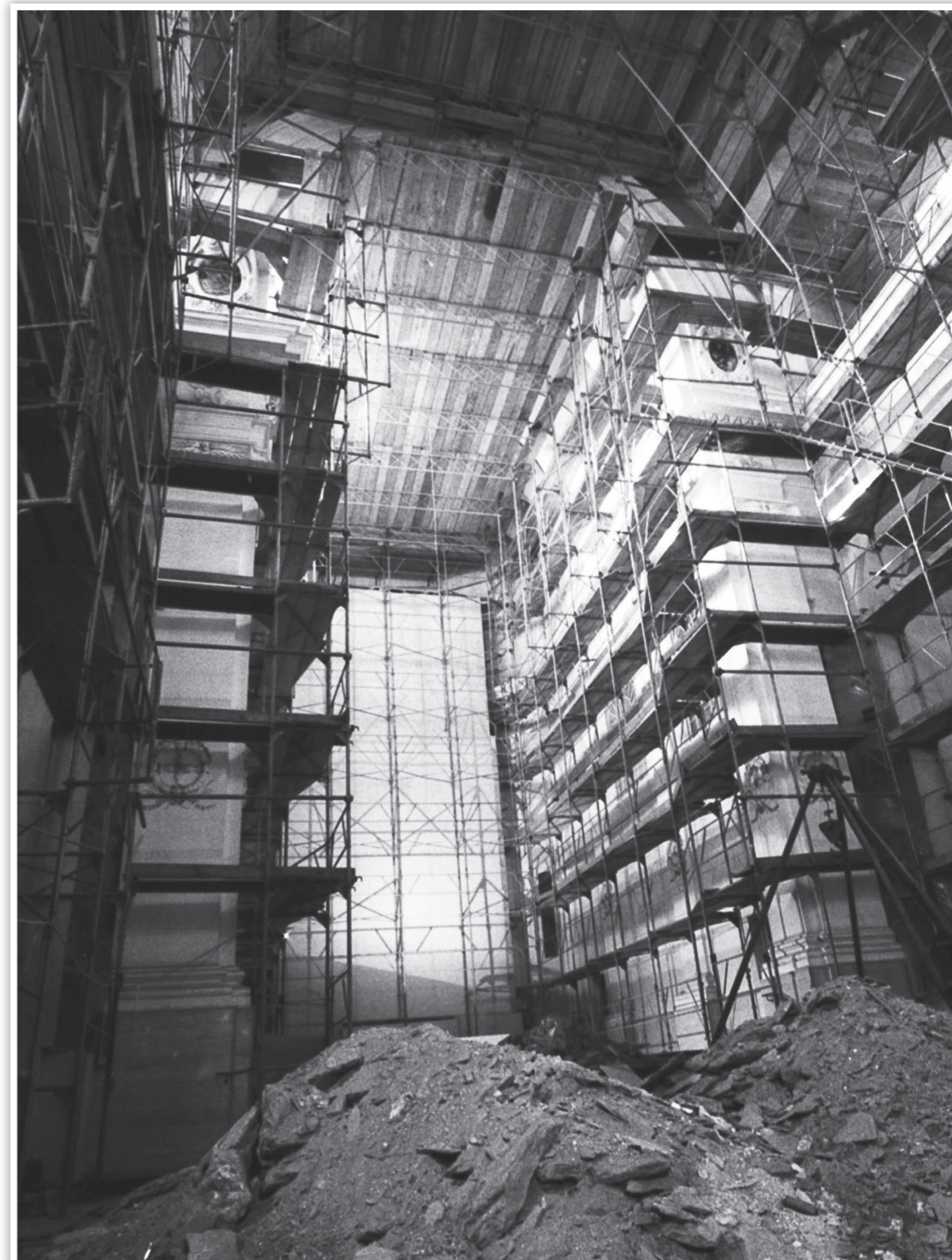
Der eingerüstete Innenraum der Kollegiumskirche.
