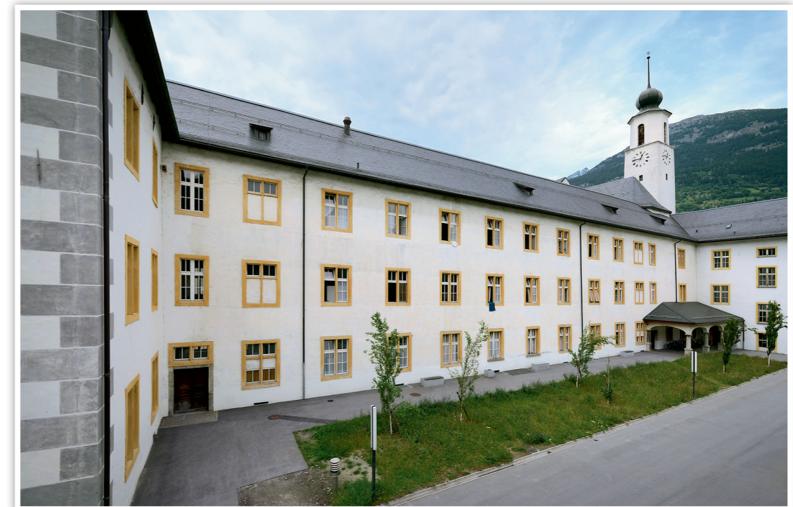
Innenhof der historischen Teile des Internates, 2012.
