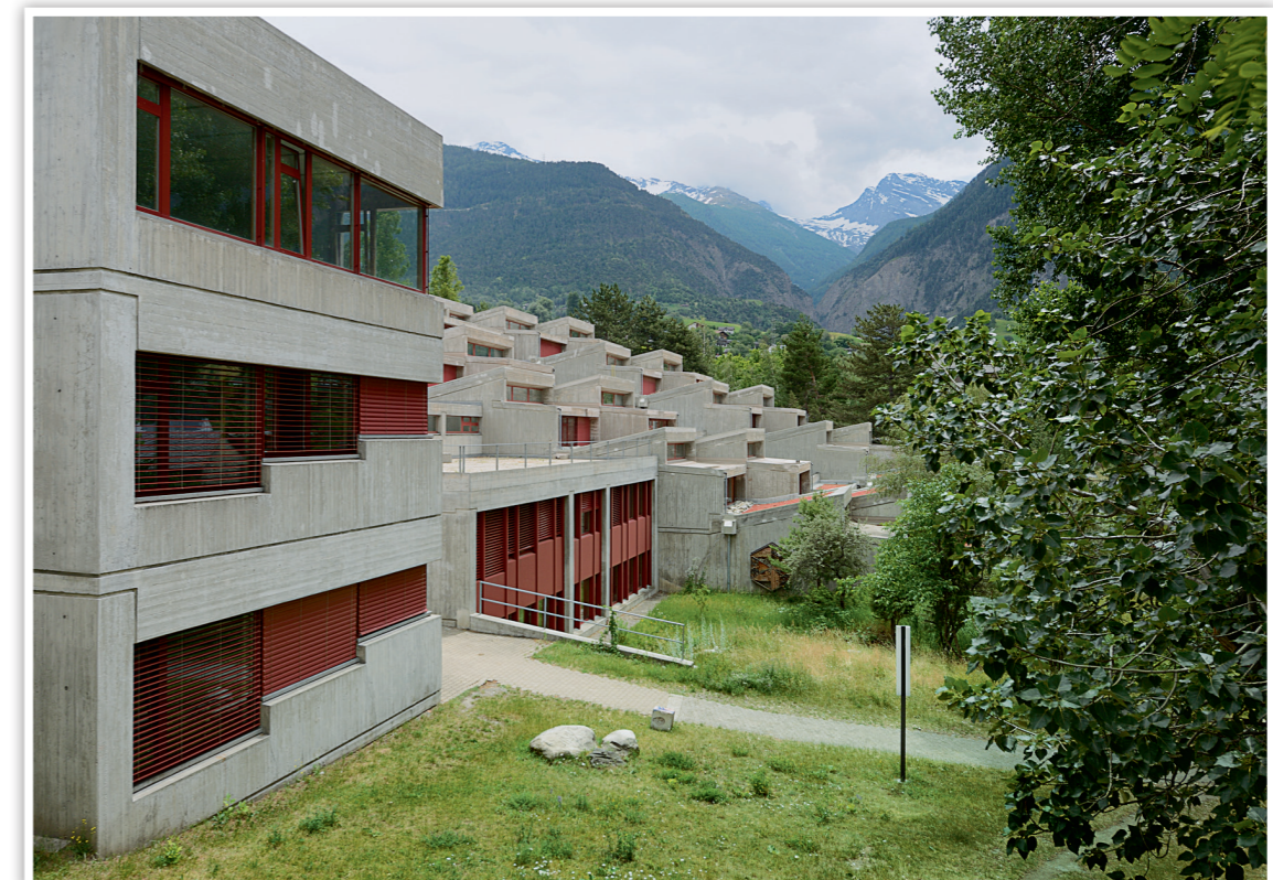
Naturwissenschaftlicher Trakt und Terrassenbau (Haus B), 2012.
