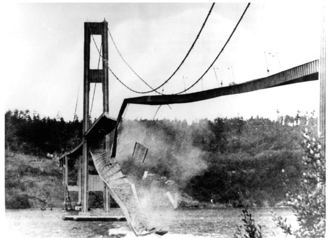
Abb 12: Tacoma-Narrows-Brücke. Der Einsturz der Tacoma-Brücke im Staate Washington 1940.
